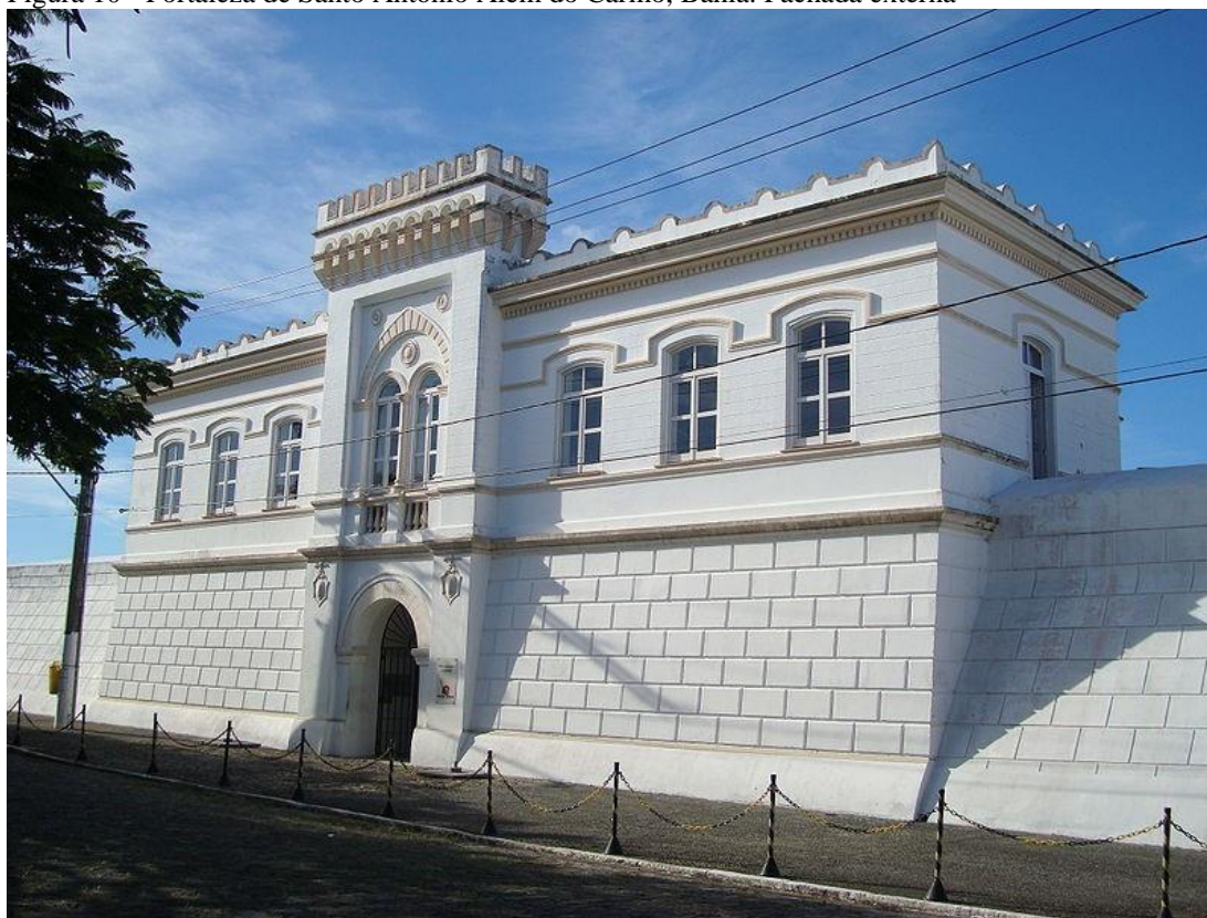
Figura 10 - Fortaleza de Santo Antônio Além do Carmo, Bahia. Fachada externa
