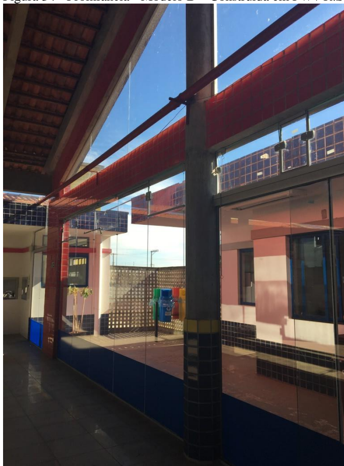
Figura 34 - Proinfância - Modelo B – Construída em FW / R.S.
