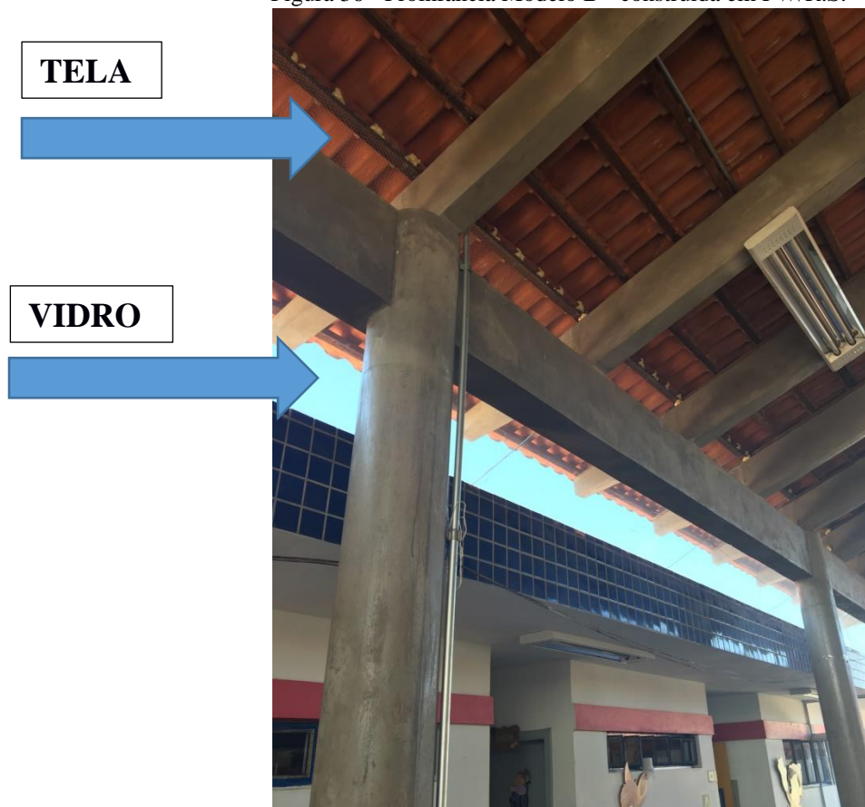
Figura 36 - Proinfância Modelo B - construída em FW/R.S.
