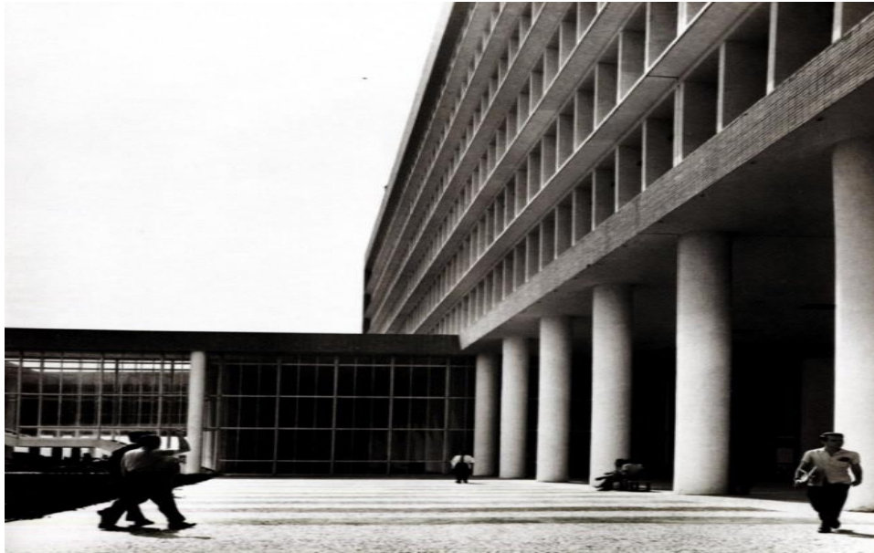
Figura 21 – Vista dos pilotis do acesso principal - FAU-UFRJ, foto de 1961.
