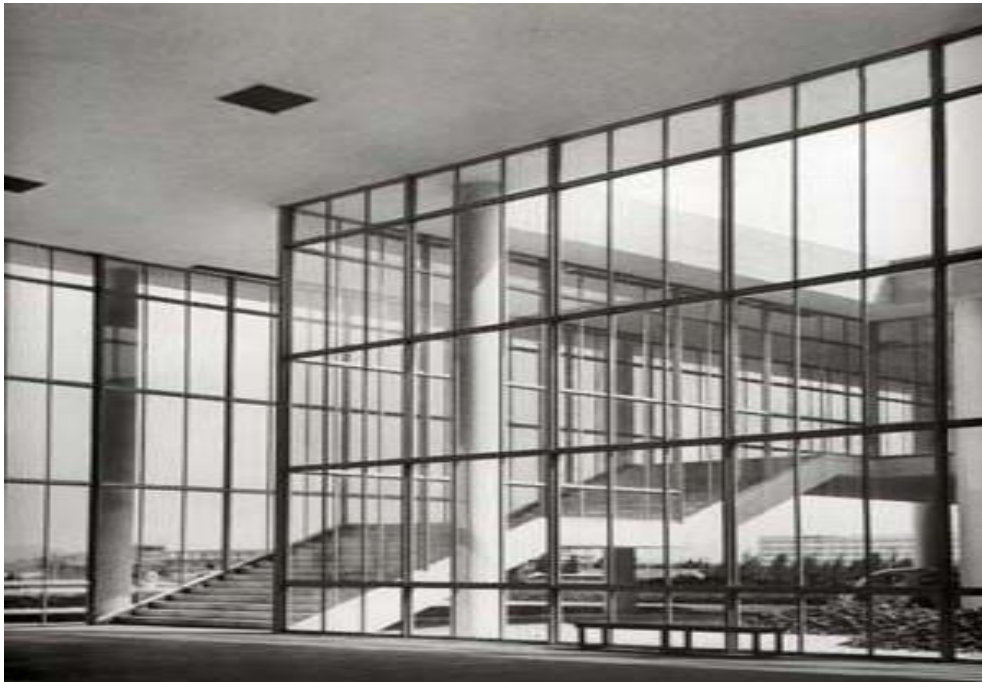
Figura 20 – Hall principal e escada de acesso à biblioteca - FAU-UFRJ, foto de 1961.
